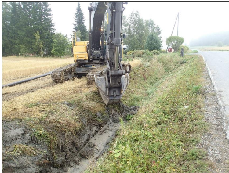
Kaivinkoneen valvonnassa avaama kaivanto tehtiin pellon ja tien väliseen ojaan. Itäkaakkoon.
