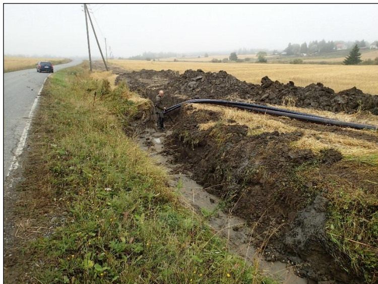
Ville Laakso tutkii valmista kaivantoa alueen länsipäässä. Luoteeseen.
