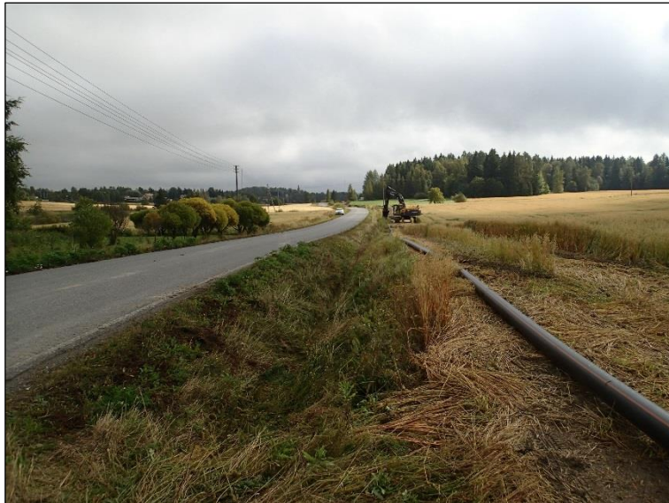
Kaivinkone valvonnassa kaivettavan linjan itäisimmässä päässä. Itään.
